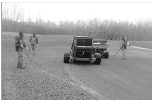
Varios operarios realizan trabajos de acondicionamiento. DL
